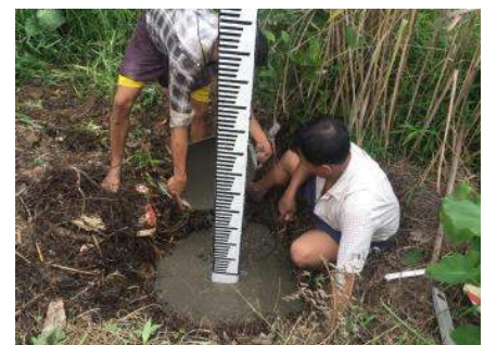
水位棒設置の様子
