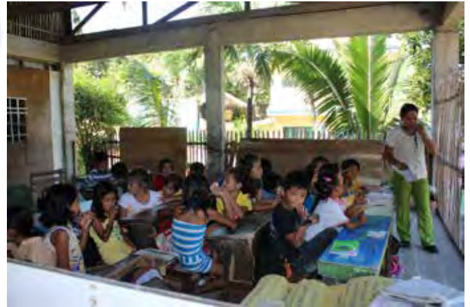
壁も窓も修復されていない状態で授業が再開
